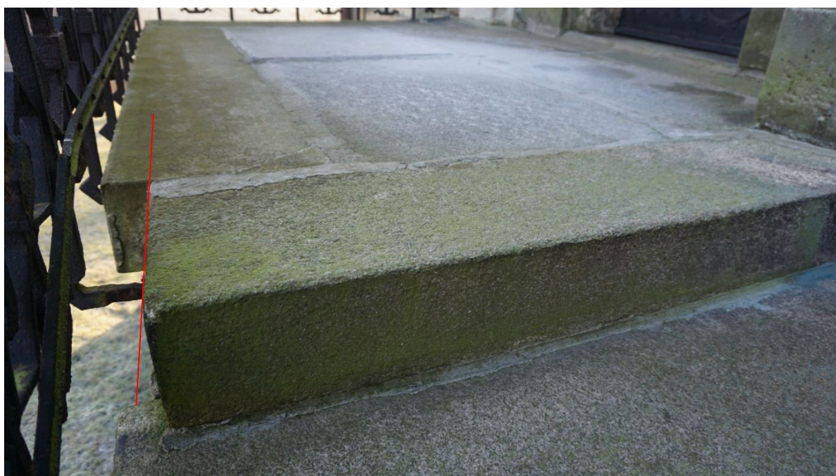
Odštíplé kusy žulových schodů, v minulosti opraveno provizorně. Nesedí rovina.
