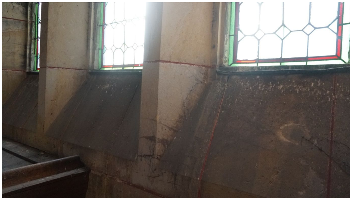
Kamenné sdružené okno na kůru. Detail poškození parapetu.
