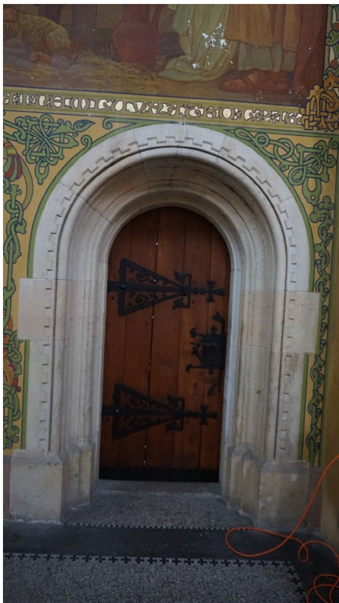
Vstupní portál z presbytáře do zákristie. Drobná poškození hran pískovce. Ulpívající prachové depozity. Zrcadlově v ose kostela opakující se motiv.
