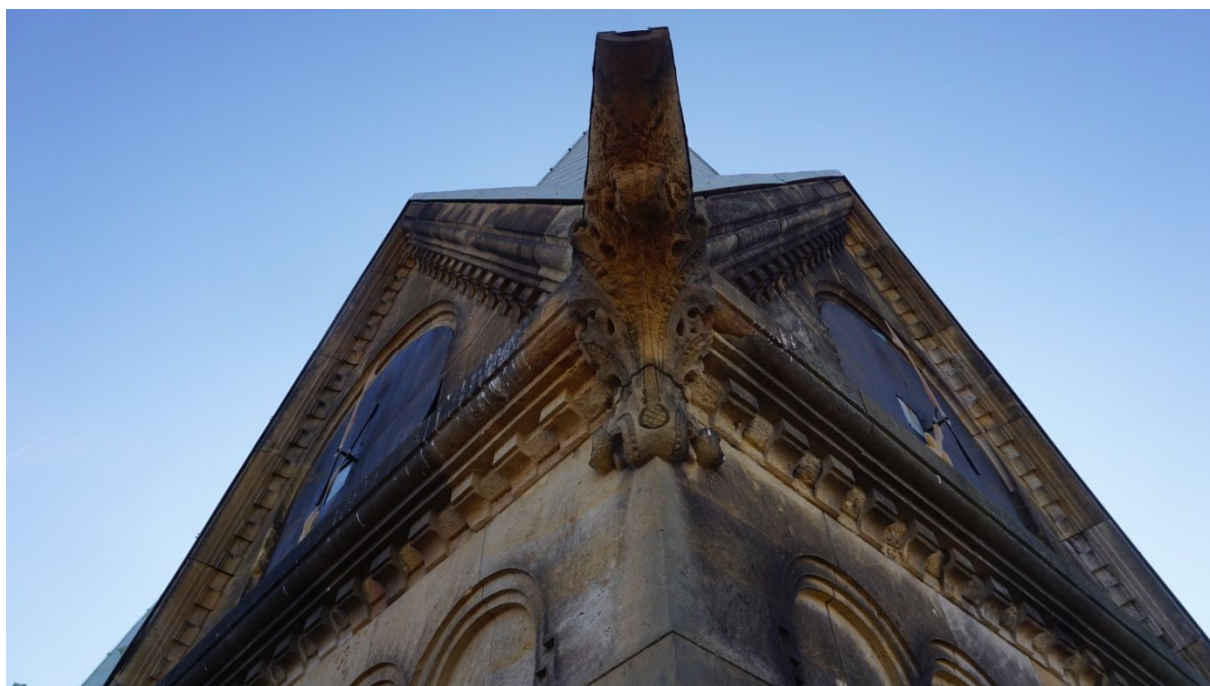
Průzkum z plošiny. Detail poškození chrličů věží.
