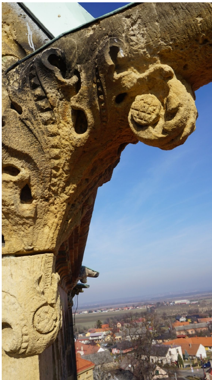
Průzkum z plošiny. Detail poškození chrličů věží.
