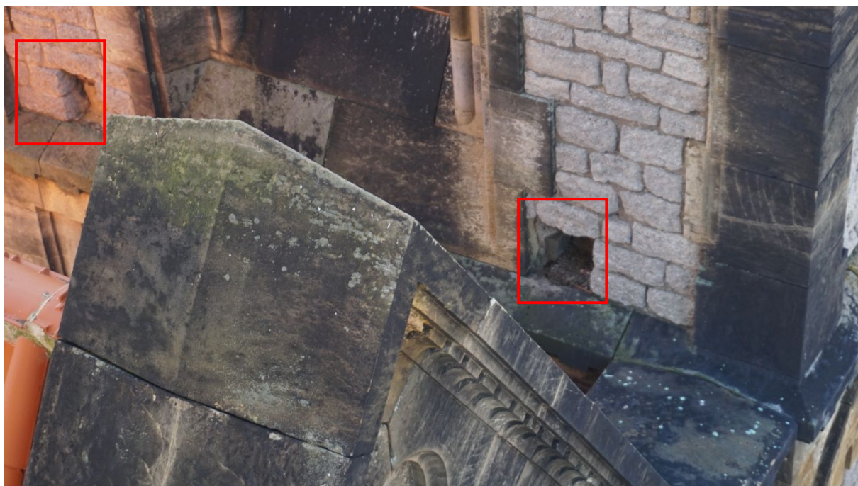
Otvory (konstrukční) na severní straně JZ věže
