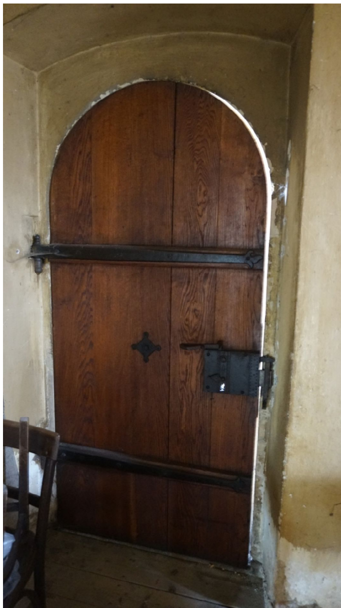
Vstupní portál z vnitřní strany křestní kaple. Drobná poškození hran pískovce. Ulpívající prachové depozity. Výmalba (okr).
