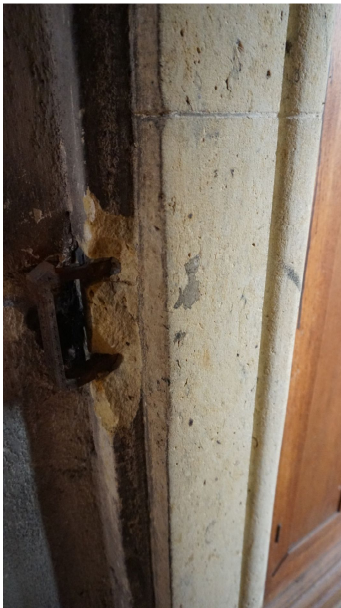
Detail poškození portálu na kůru kostela. Směr dmychadlo varhan.
