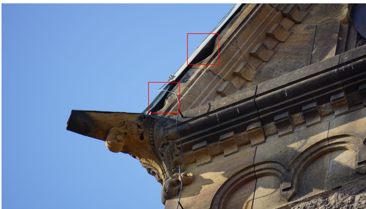
Západní průčelí kostela. Průzkum z plošiny. Detail poškození. Mohutné chrliče z jednoho bloku kamene včetně navazujícího zubořezu.
