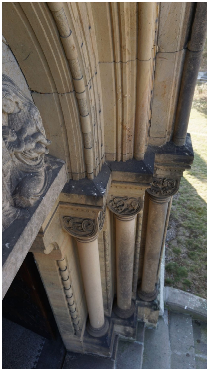
Západní průčelí kostela. Průzkum z plošiny. Detail poškození.
