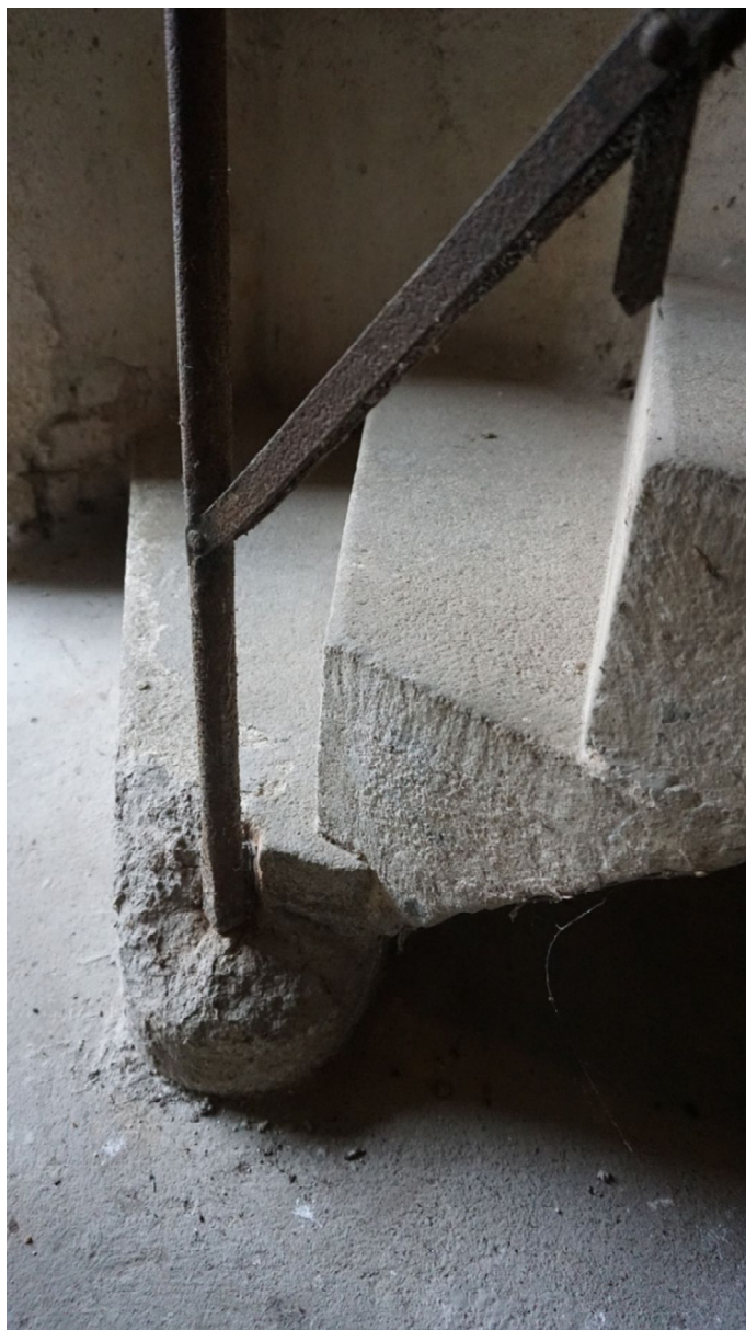
Poškozený žulový schod točitého schodiště SZ věže.
