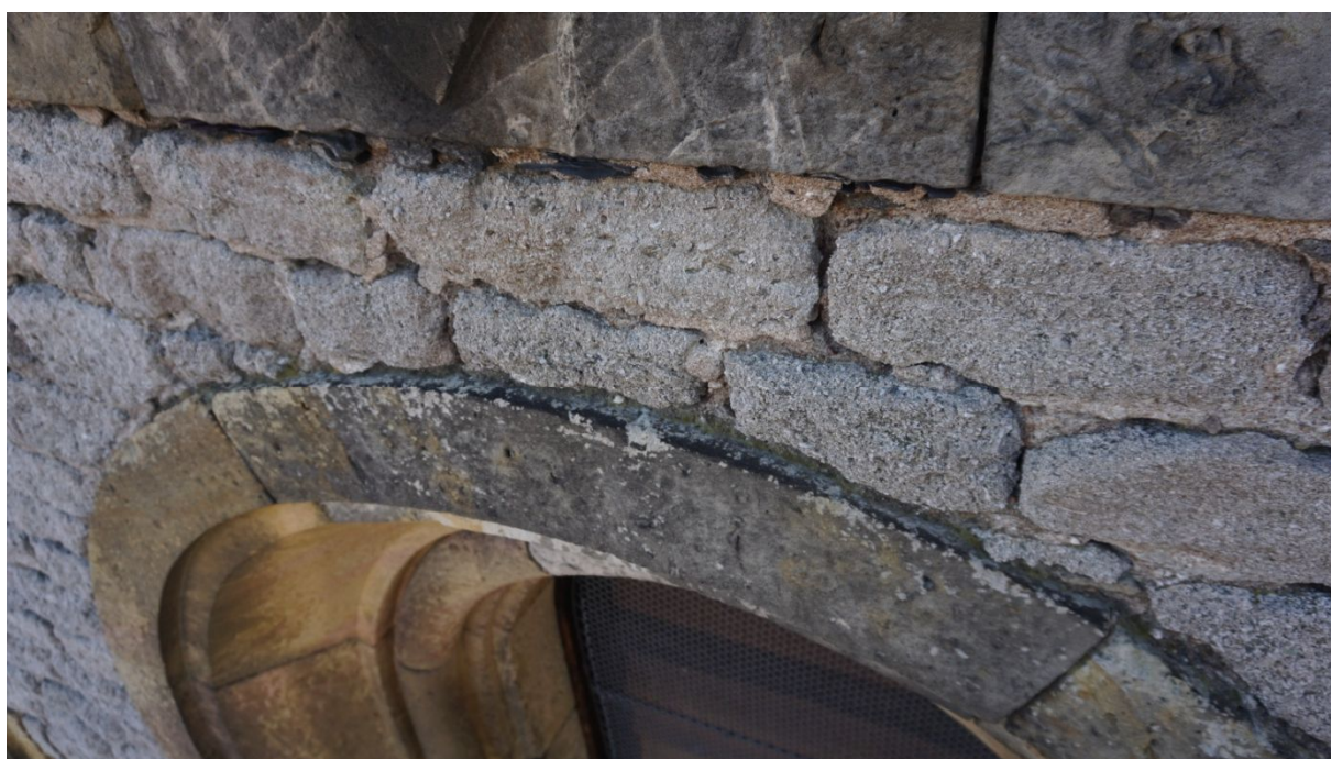
Západní průčelí kostela. Průzkum z plošiny. Detail poškození. Absence spár.
