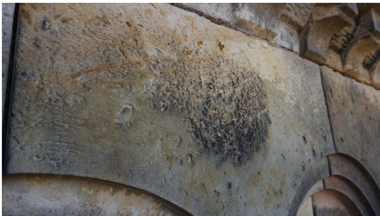
Západní průčelí kostela. Průzkum z plošiny. Detail poškození. Biologické depozity.
