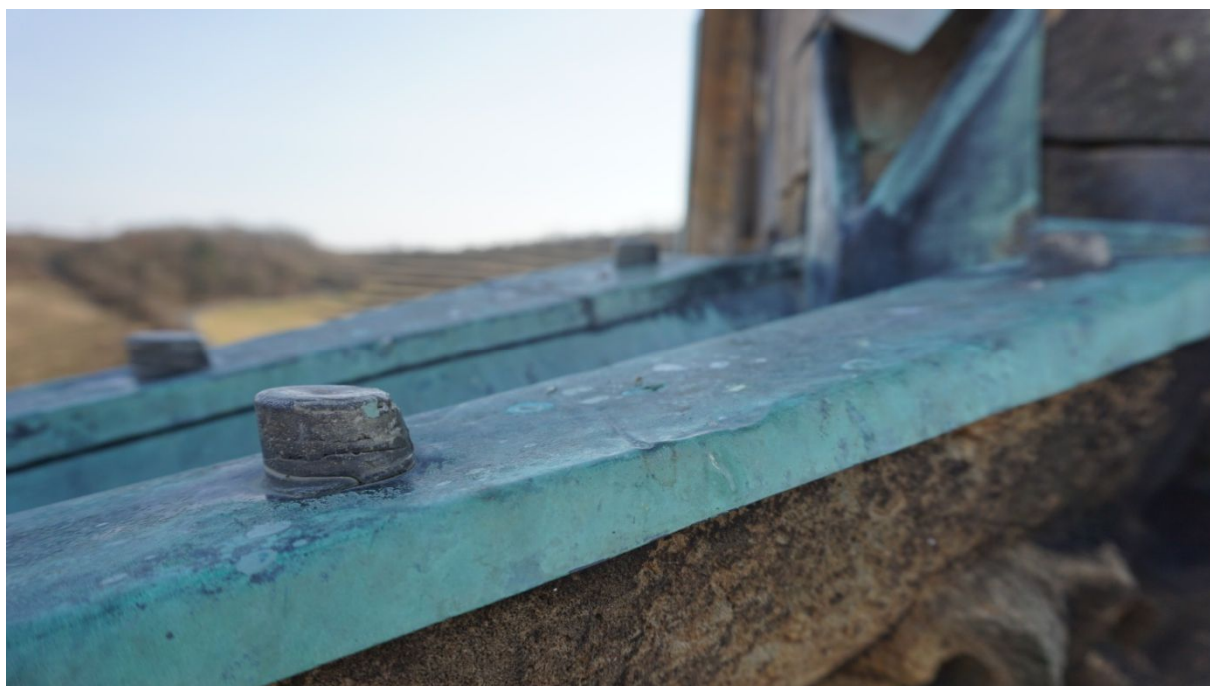
Průzkum z plošiny. Detail poškození chrličů věží. Oplechování
