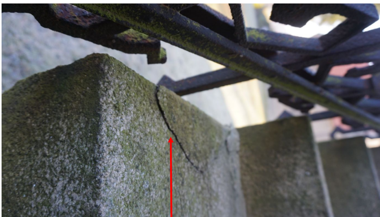
Severní strana kostela, žulové schodiště do křestní kaple. Detail poškození.
