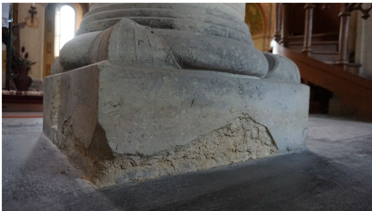
Detail poškození patky sloupu. Doporučuji vyspravit minerálním tmelem až po přebroušení terasové podlahy.
