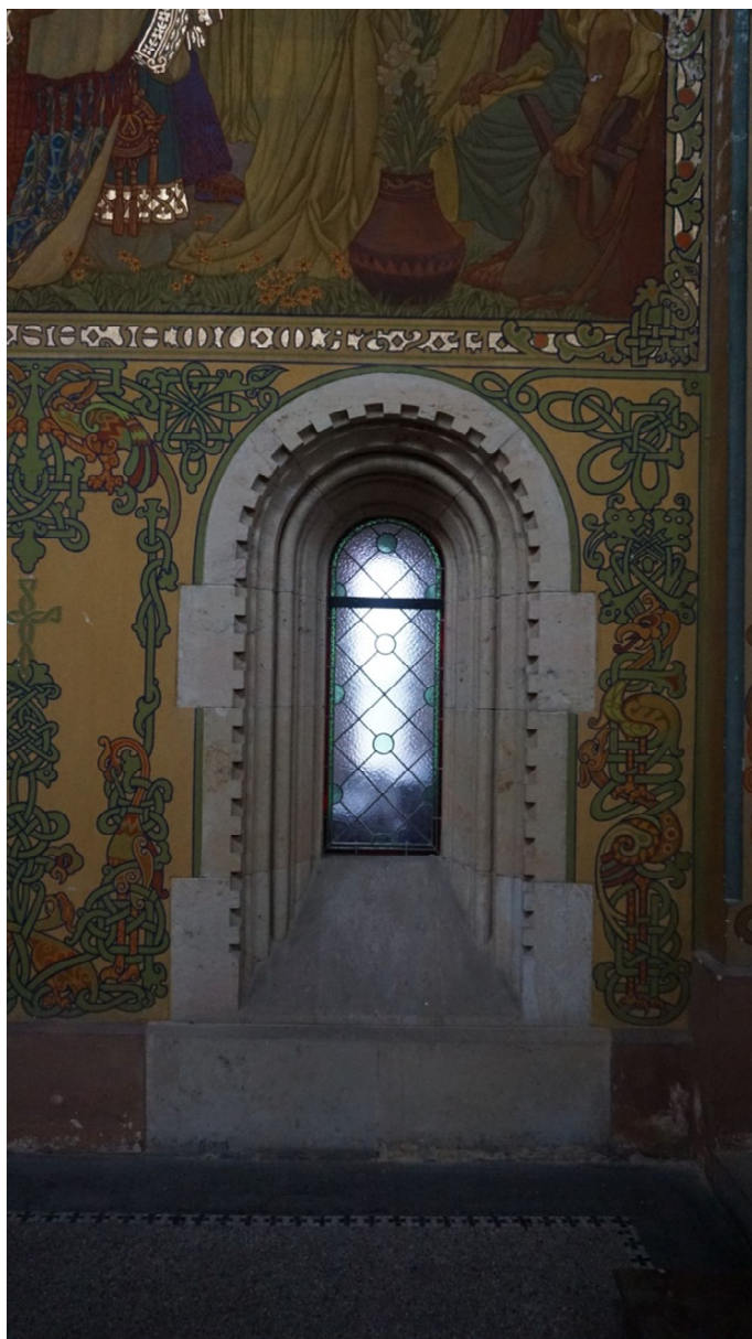
Kamenné okno z presbytáře do zákristie. Drobná poškození hran pískovce. Ulpívající prachové depozity. Zrcadlově v ose kostela opakující se motiv.
