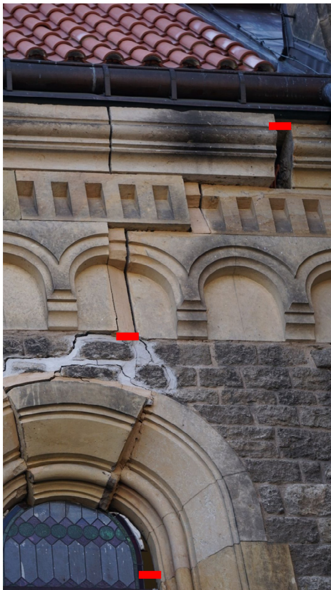
Severní strana kostela, statická trhlina, uvolnění klenáku okna. Detail. Červeně je vyznačena šířka rozestupu – praskliny. Havarijný stav.
