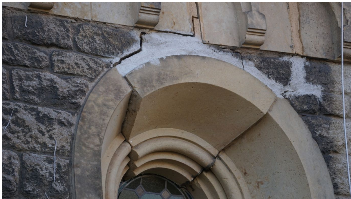
Severní strana kostela, statická trhлина, uvolnění klenáku okna. Detail. Havarijní stav.
