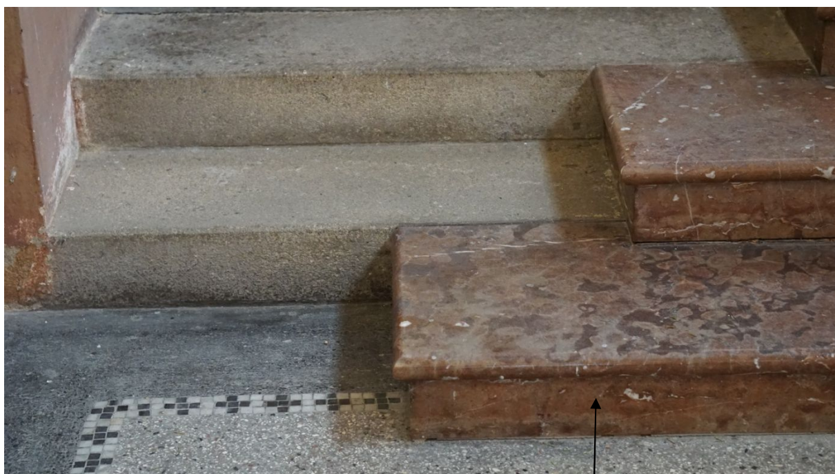
Žulové schodiště po stranách hlavního oltáře. Uvolněný mramorový schod od podkladu (broušené terasové podlahy). Presbytář kostela.
