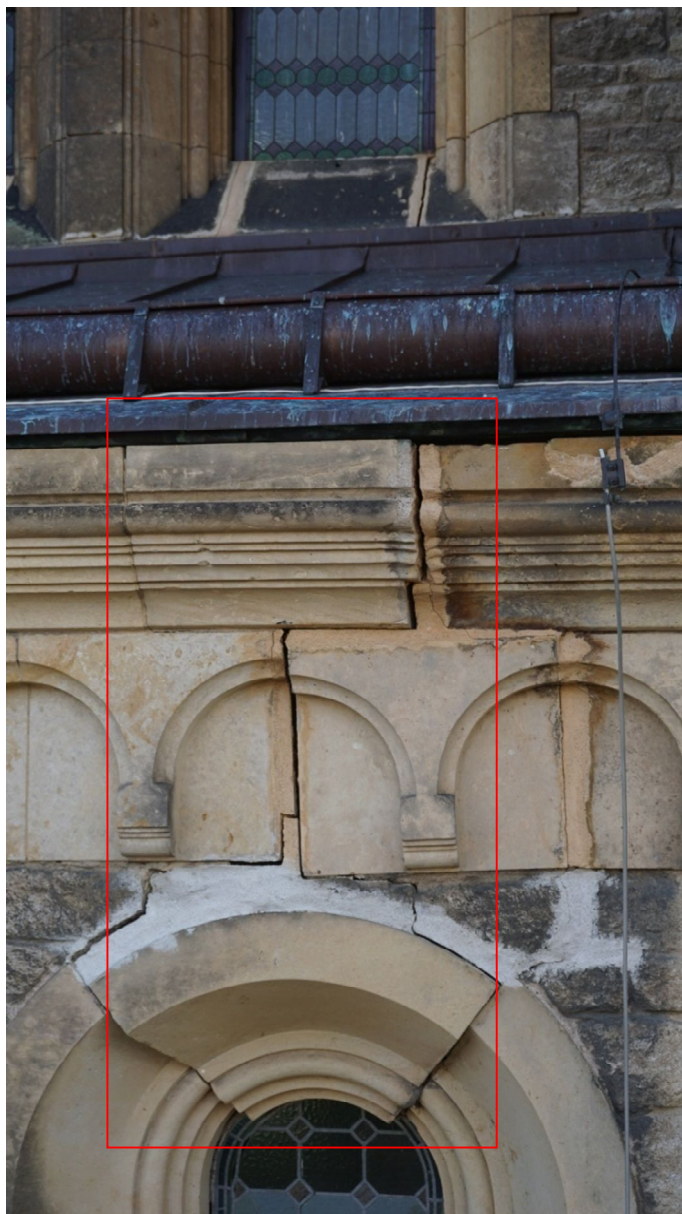
Severní strana kostela, statická trhлина, uvolnění klenáku okna. Detail. Havarijní stav.
