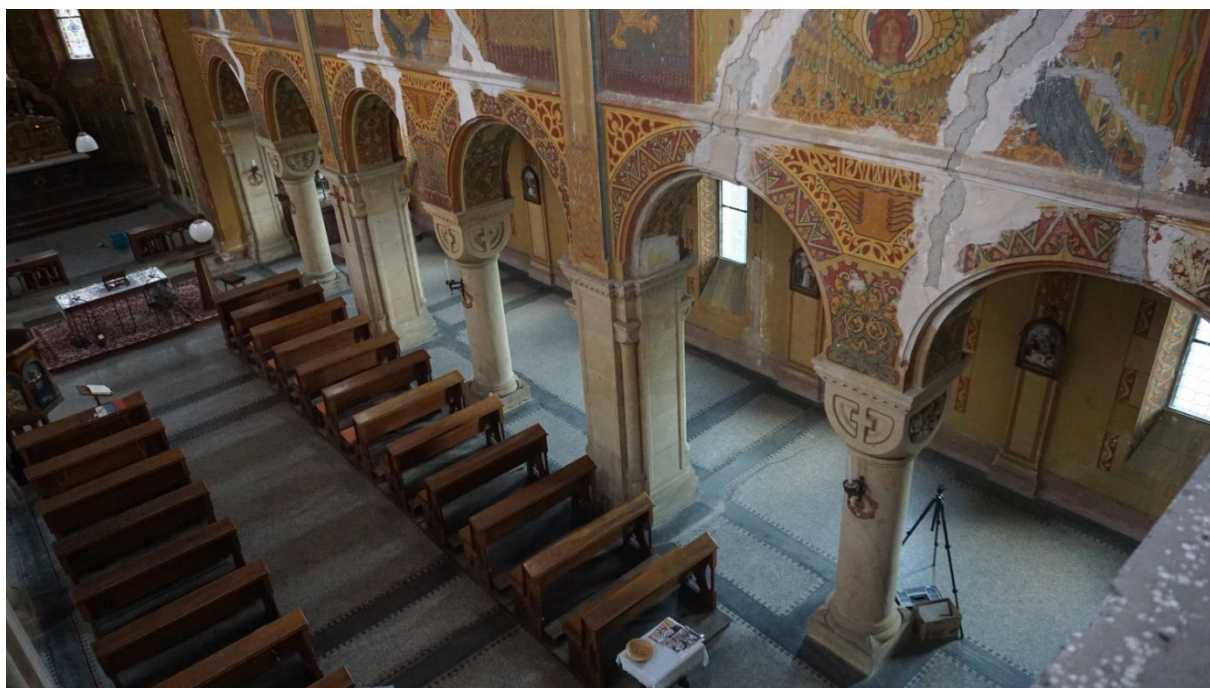
Celkový pohled do hlavní lodi kostela. 4 ks kamenné pilíře, 6 ks kamenných sloupů, 4 ks pilastry. Kámen je bez barevného pojetí. Pouze na sloupech (ornament pod svícnem) ozdobné hlavice (obrysová linie – zlato). Přehled poškození.
