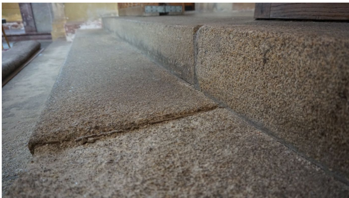
Žulové schodiště pod vítězným obloukem. (hlavní loď/presbytář). Problém šupinkovité oddělování vrstev kamene. Vyšší obsah salinity.
