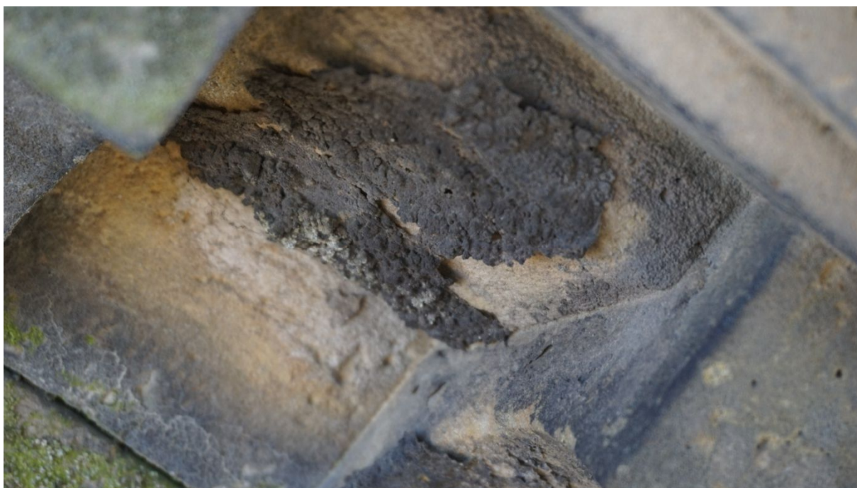
Západní průčelí kostela. Průzkum z plošiny. Detail poškození. Krusta.
